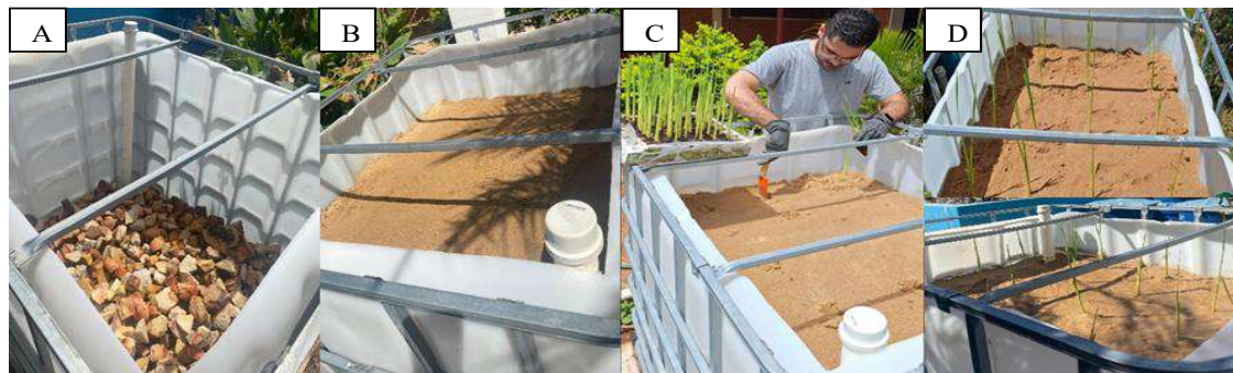
Figura 1. (A) Acondicionamiento con gravas capa inferior e intermedia, (B) Capa superficial arena gruesa (C) siembra de macrófitas en el humedal (D) plantines sembrados.
