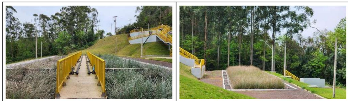
Figura 3. Humedal para lodos sépticos (SW, izquierda) y humedal para lixiviados (LW, derecha).
