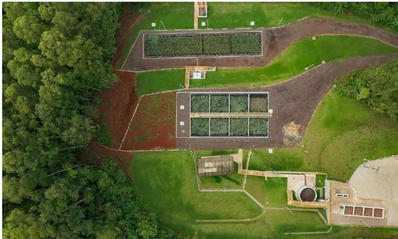
Figura 2. Fotografía aérea con dron de la Unidad de Gestión de Lodos Sépticos de Descanso.
