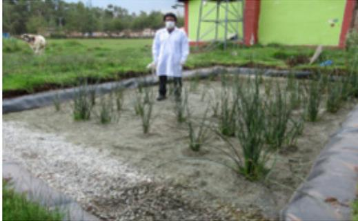
**Figura 4a.** Humedal construido de tipo subsuperficial horizontal en la I.E. 50106.
