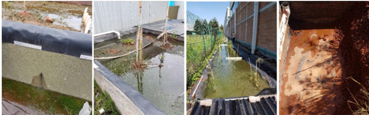
**Figura 3.** Vista de izquierda a derecha, problemas constructivos asociados a filtraciones, colmatación y perforación de la geomembrana.
